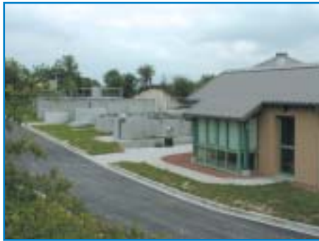
Station d'épuration de Méricourt-l'Abbé
