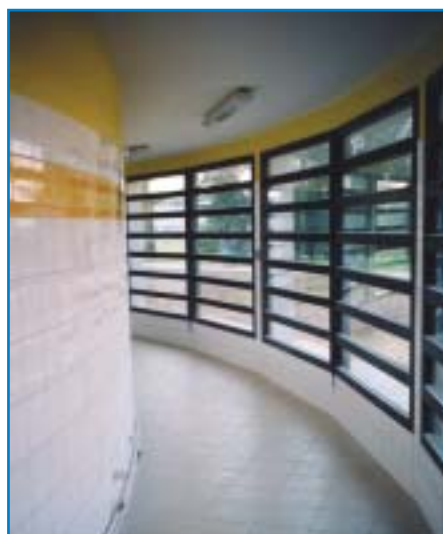
Travaux de réhabilitation et d'extension coût : 577 216 euros dont 168 949 euros subventionnés par le Conseil général de la Somme
