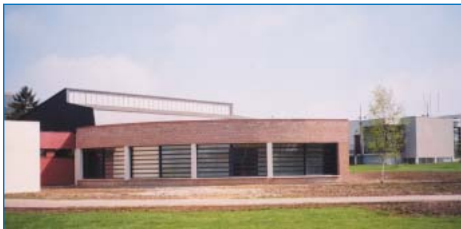
Mise en conformité et travaux d'entretien coût : 151 839 euros dont 37 960 euros subventionnés
