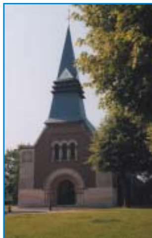
Le parvis de l'église de Marcelcave va subir des travaux d'amélioration
