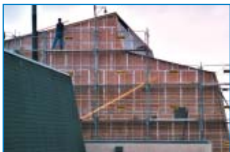
Toiture et bardage de la structure, coût : 202 161,28 € subvention Conseil général : 54 515,77 €
