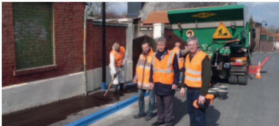
et il n'a pas besoin de déposer les bordures. "C'est un produit constitué de sable, d'une émulsion de bitumes et de différents adjuvants des matériaux locaux. Cela fait partie de notre démarche de développement. Nous devons nous adapter. Les communes n'ont plus les moyens de refaire systématiquement les trottoirs. C'est un moyen de réhabiliter les trottoirs et allées endommagées sans gêne pour les riverains car ce revêtement est rapide à mettre en œuvre" montrait
