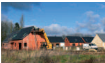
Lotissement en construction à Marcelcave
