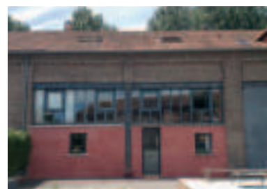
Transformation d'une friche à Daours ©ADUGA
