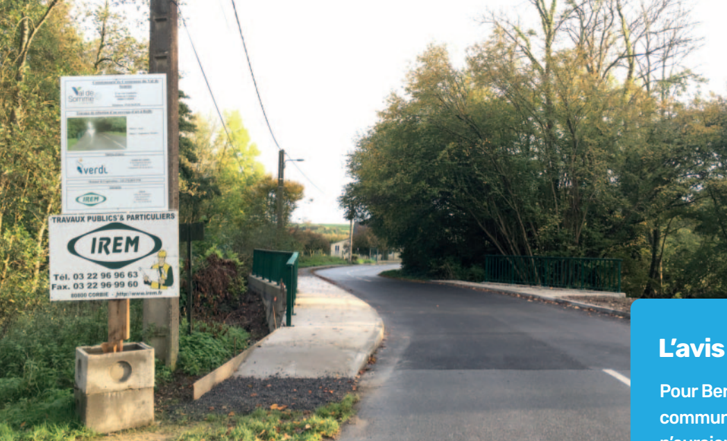
À Heilly, après la 1 ère partie des travaux
