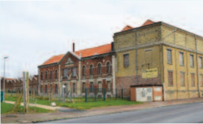
Friche industrielle, ancienne usine Mailcote, Villers-Bretonneux
