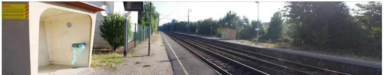
Absence de bancs dans les abris d'attente des trains. Pas de bandes podotactiles sur les quais
