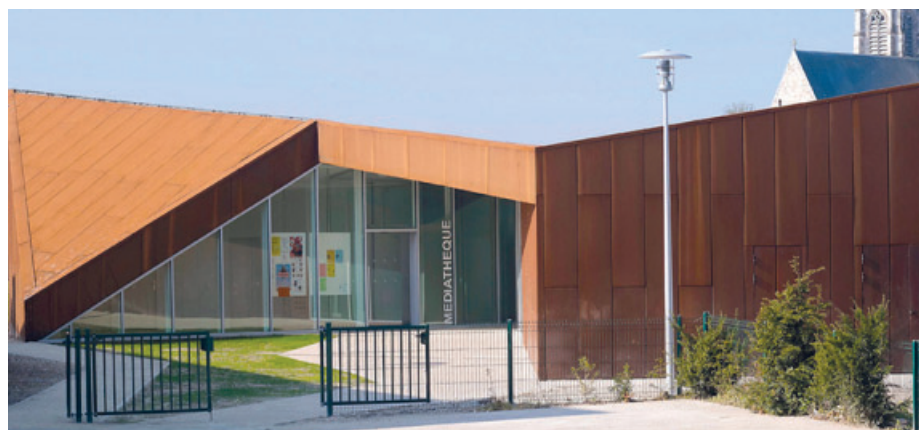
L'entrée de la médiathèque à Corbie
