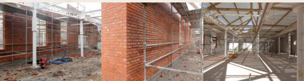
Les travaux à la "Filature" de Ribemont-sur-Ancre
