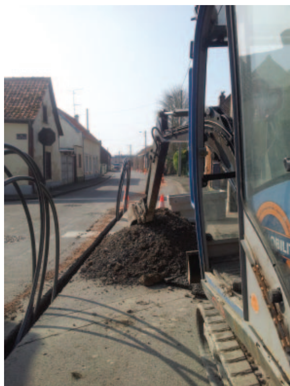
Photo des travaux lors de la création du réseau fibre à Corbie
