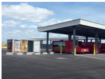
Deux déchetteries intercommunales situées à Corbie et à Villers-Bretonneux
