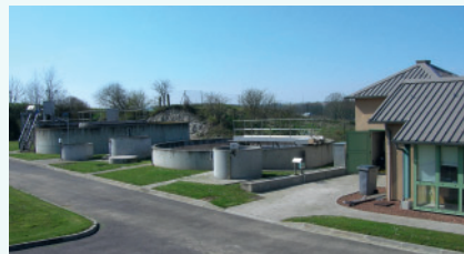
7 stations d'épuration – 78 postes de refoulement et 120 km de réseaux
