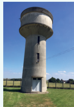
Un réseau d'eau potable de 173,5 km traversant 24 communes
