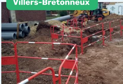
Travaux de création du réseau d'eau pluviales de la RD1029 pour la tranche 2. Travaux réalisés par la société IREM
