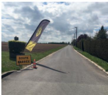
**CACHY** : Rue des Blés Mûrs, réfection de la voirie (terrassement, pose de bordures et caniveaux, rabotage de la voirie en place, et réalisation d'un nouvel enrobé de chaussée)
