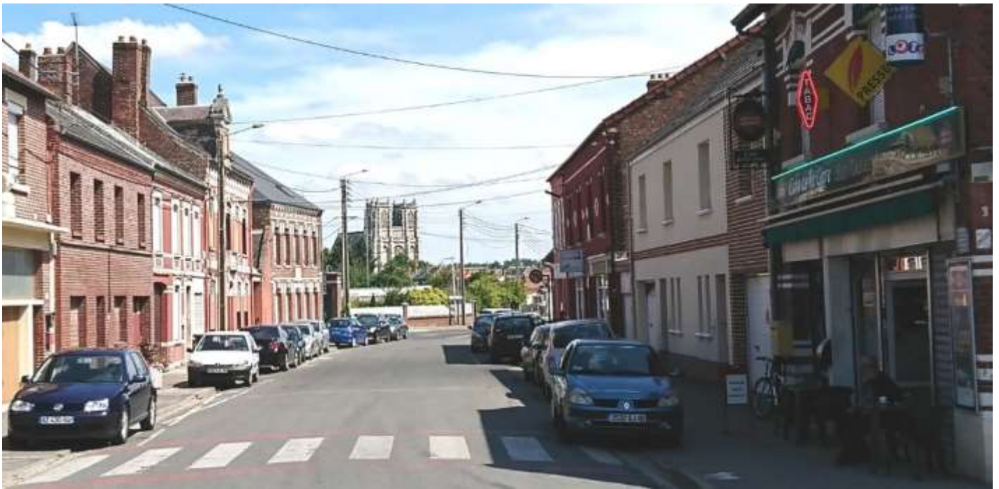
L'axe de liaison Gare – Centre-ville (rue Léon Curé) : perspective sur les tours de l'Abbatiale depuis la démolition de la friche BVR
