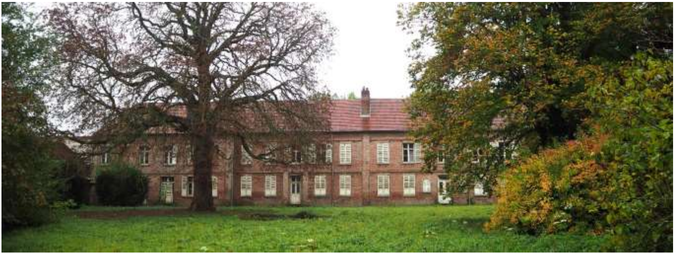
La façade arrière du logement patronal
