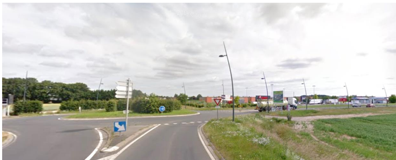
Giratoire situé à l'intersection de la RD 23 et de la chaussée du Val de Somme
