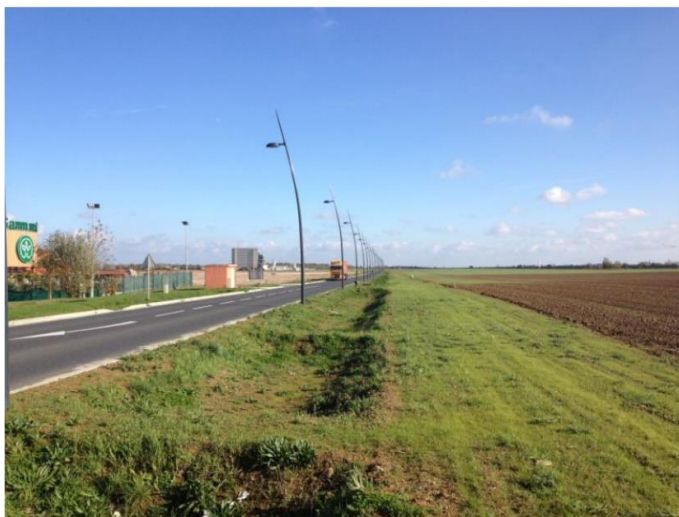
Constitution du système de noues de chaque côté de la chaussée du Val de Somme
