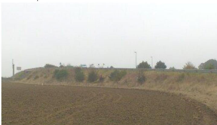
Le talus présent sur la zone d'étude
