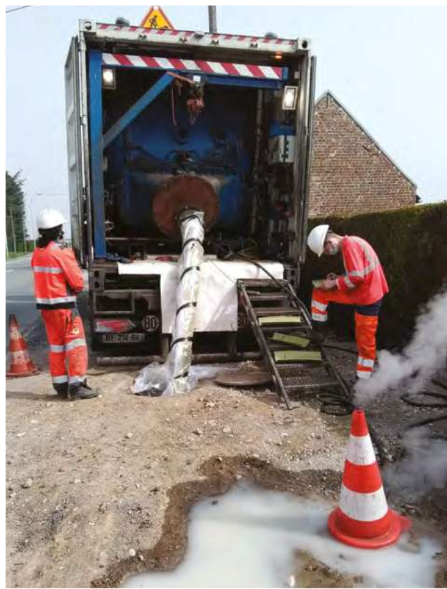
Travaux d'assainissement sur la RD 1029
