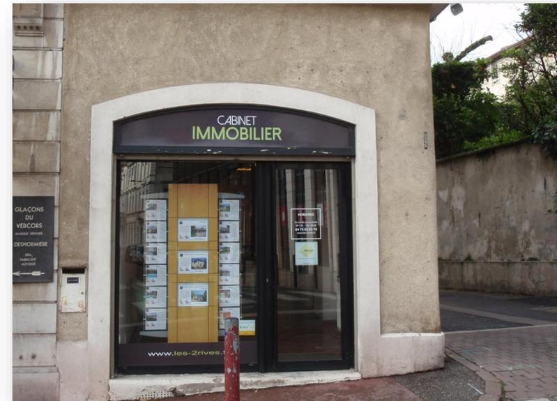
\* La vitrine en feuillure est une devanture vitrée dans un châssis posé en feuillure dans l'épaisseur du mur, en retrait par rapport au nu extérieur de la façade.
